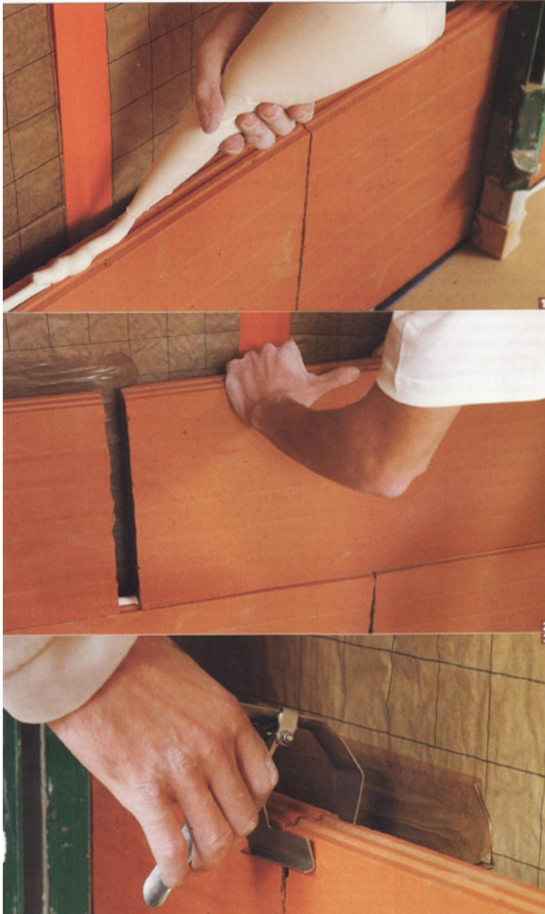
**MONTAGE D'UNE CLOISON DE BRIQUES EN TERRE CUITE :** (1) après avoir tiré un cordon de colle à base de plâtre sur le premier rang, (2) le deuxième rang est ici monté à deux mains – manipulation rendue possible par l'utilisation de briques de grand format. (3) Des pinces sont utilisées pour bien aligner les briques entre elles sur les cueillies.
